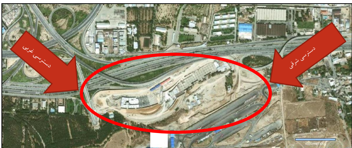
شکل ۱-۳- دسترسی غربی و شرقی پایانه شرق جدید
