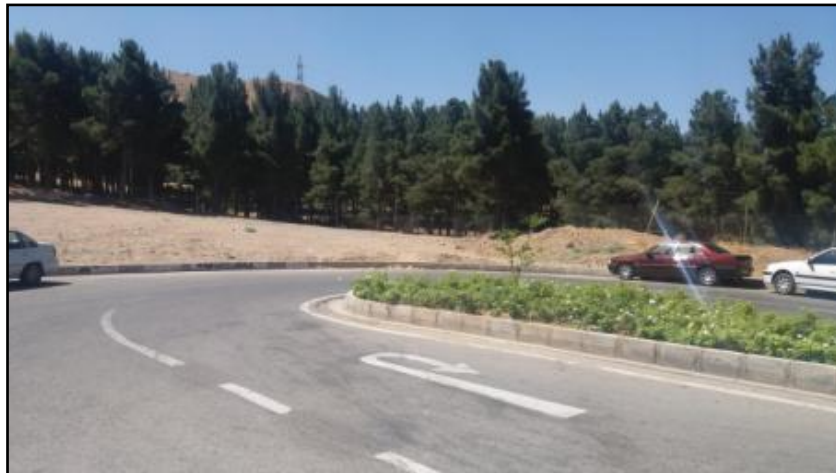
شکل ۲-۸- دوربرگردان واقع در انتهای پل روگذر و درب غربی پایانه
