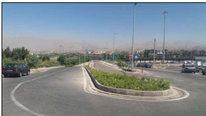
شکل ۲-۹- دوربرگردان واقع در انتهای پل روگذر و درب غربی پایانه
