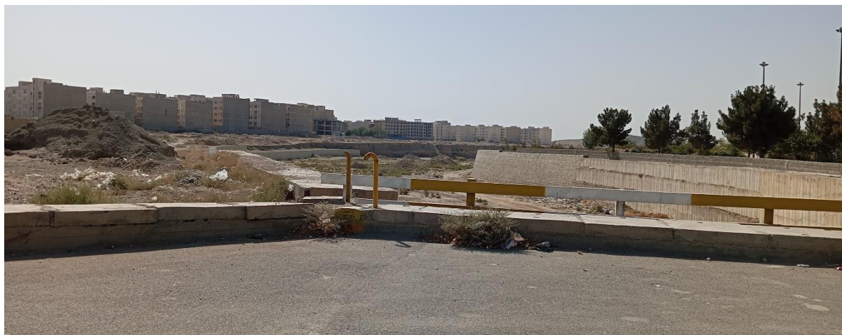
شکل ۱-۱۰۷ عبور مسیر از زیر رودخانه
