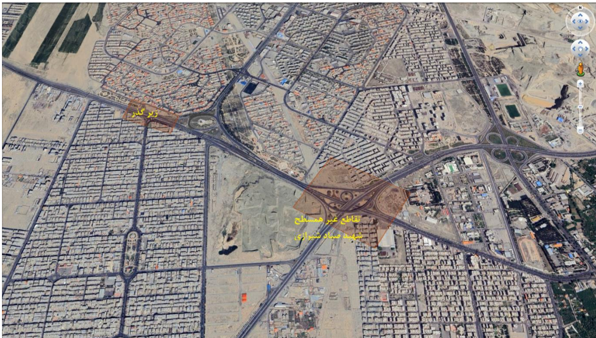
شکل ۱۰-۵: زیرگذر و تقاطع غیر هم‌سطح موجود در مسیر
