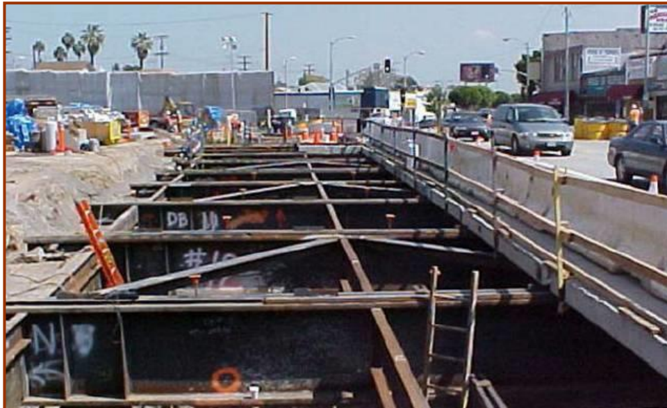
شکل ۳-۳: اجرای ایستگاه به روش ترانشه بسته
