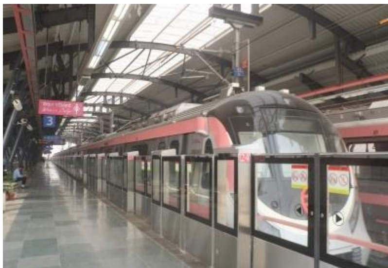
شکل ۱۴-۳: ساخت سقف ایستگاه با استفاده از تیرورق
