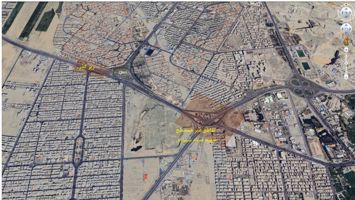
شکل ۳۵-۵: زیرگذر و تقاطع غیر هم‌سطح موجود در مسیر
