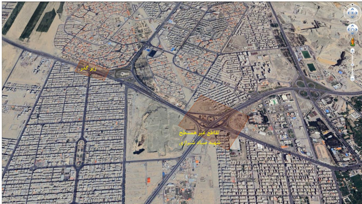
شکل ۳۰-۵: زیرگذر و تقاطع غیر هم‌سطح موجود در مسیر
