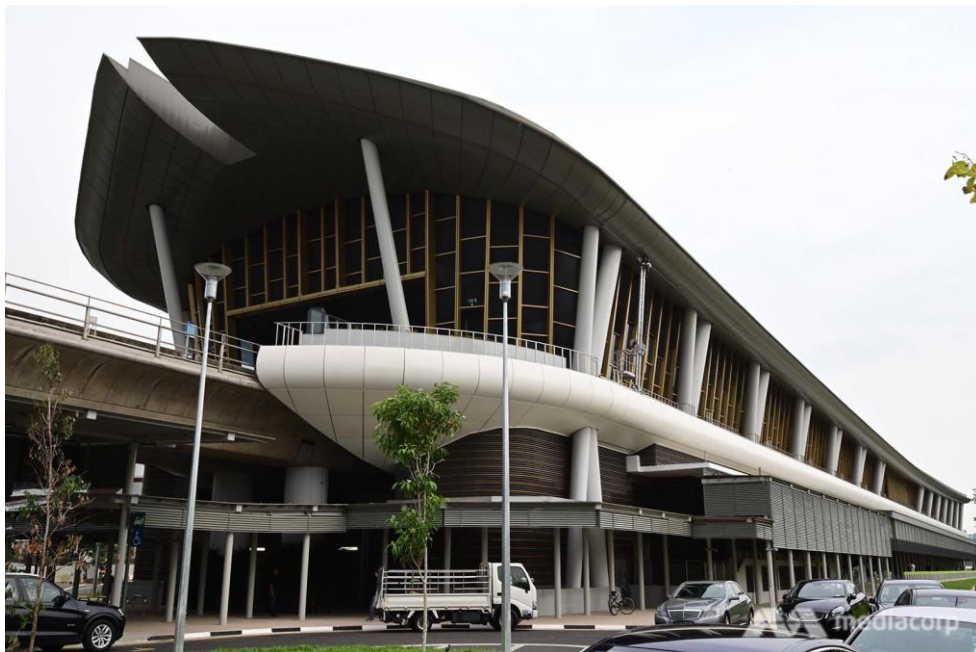
شکل ۱۹-۳: اجرای سازه ایستگاه با معماری دلخواه
