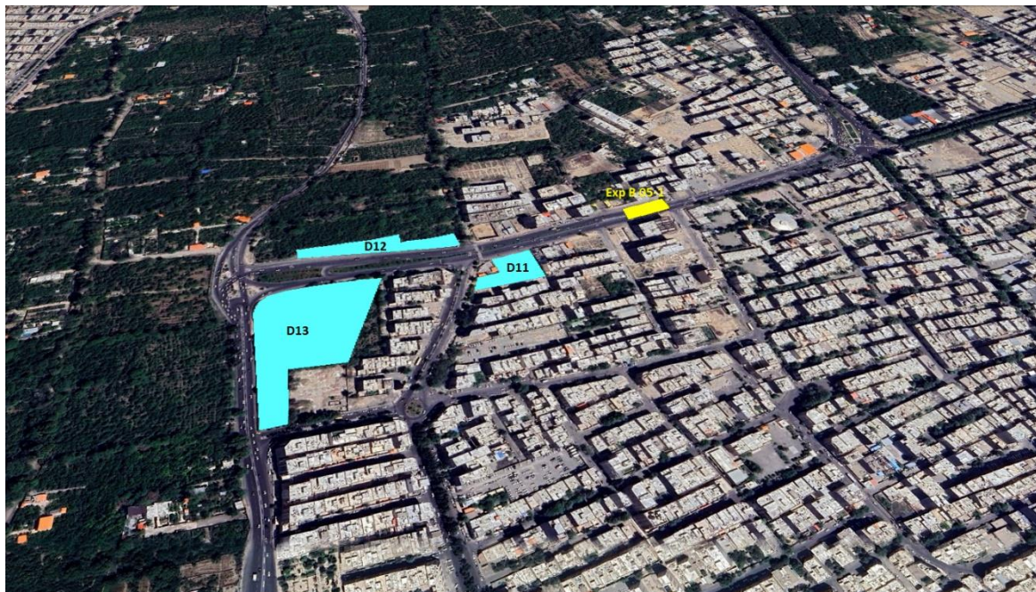
شکل ۴-۸۶: محل‌های تجهیز کارگاه پیشنهادی در محدوده ایستگاه شهریار - علامه طباطبایی (Exp B 05-1)
