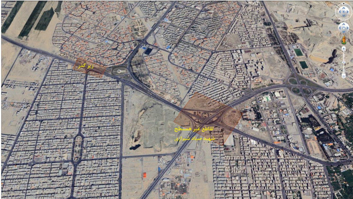
شکل ۲۰-۵: زیرگذر و تقاطع غیر هم‌سطح موجود در مسیر
