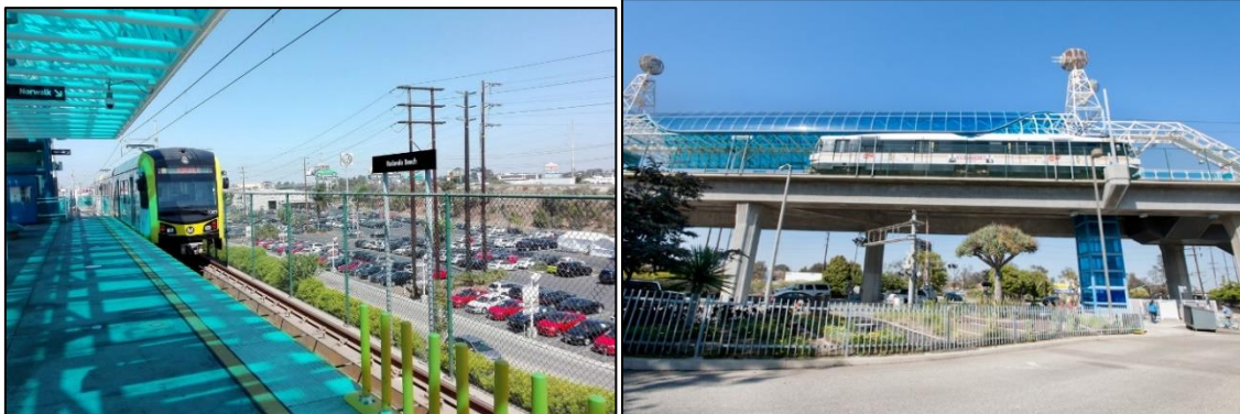
شکل شماره 7-442: ایستگاه Redondo Beach Station
